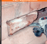
Verwijderen en repareren van bakstenen
